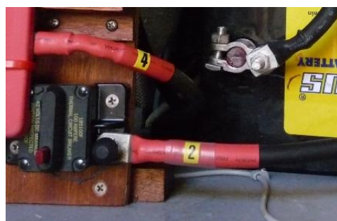
Bild: Kennzeichnung mit selbstklebenden Etiketten oder Nummern
