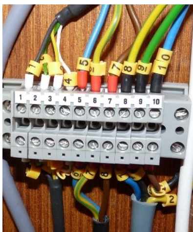
Bild: kleine Clipse mit Nummern kennzeichnen die Kabel
